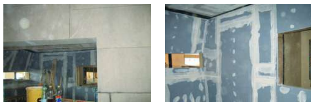
Construcción de un estudio de radiodifusión con láminas pesadas Idikell
