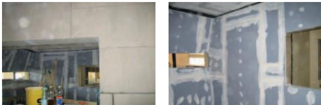
Construcción de un estudio de transmisión con láminas pesadas Idikell®
